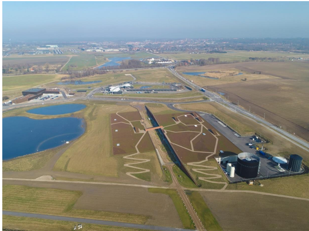
Figur 21 Hillerød Renseanlegg i Solrødgaard Miljøpark nord for København.
