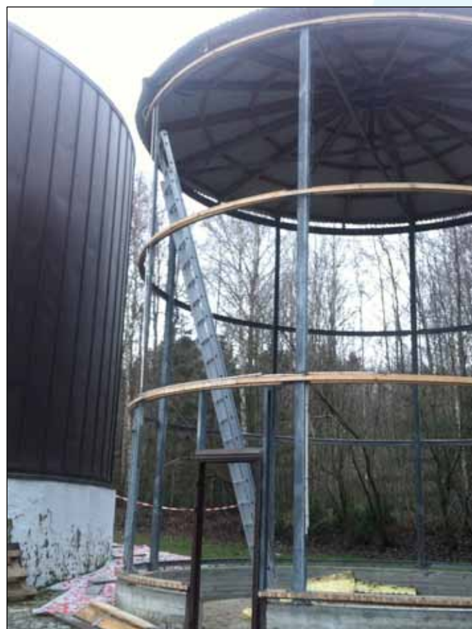
Riving av gammel gasstank ved Fuglevik Renseanlegg
