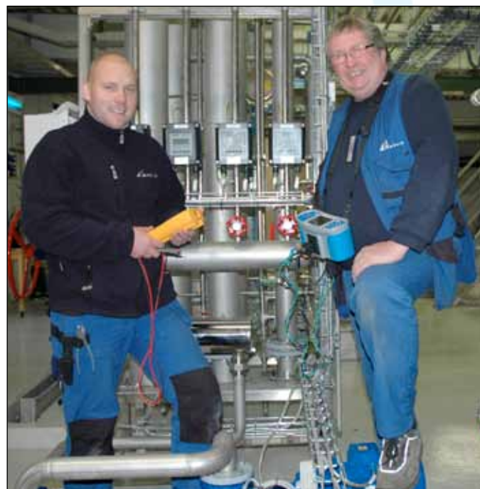
Elektrikerne Jan Anders Wasenius t.v. og Per-Christian Rasmussen installerer utstyr i Pilotanlegget på Vansjø Vannverk
