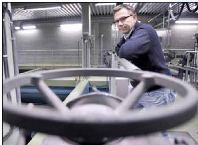
Sektorsjef Johnny Sundby inspiserer vannfilteret
