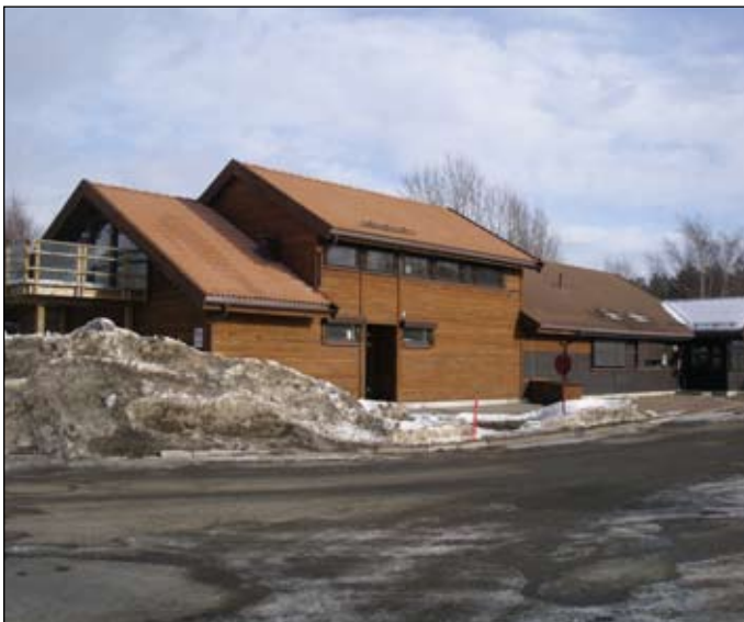
Tilbygget til administrasjonsbygget på Solgård Avfallsplass som ble ferdigstilt i 2010
