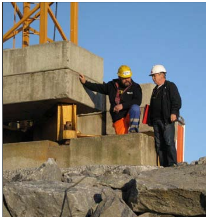
Prosjektleder Hans Wold på befaring ved Hestevold Renseanlegg
