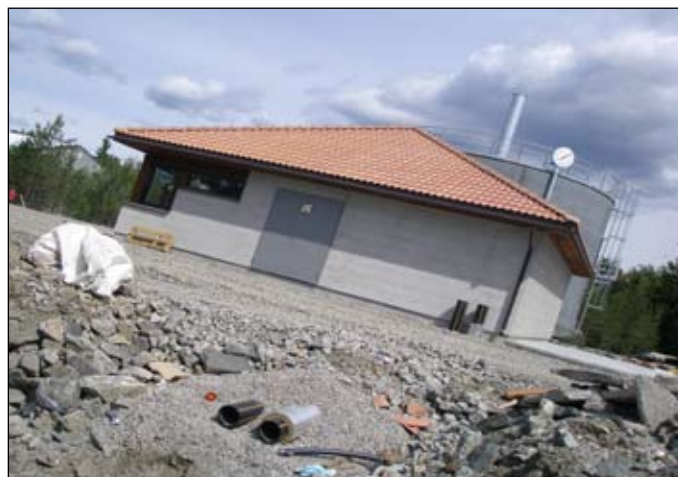
Gassfordelingsentral i forgrunn og gassklokke i bakgrunn
