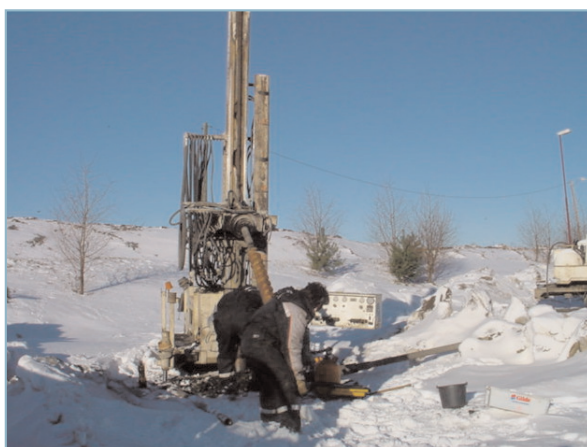
Borring av brønn for analyser i deponiet.
