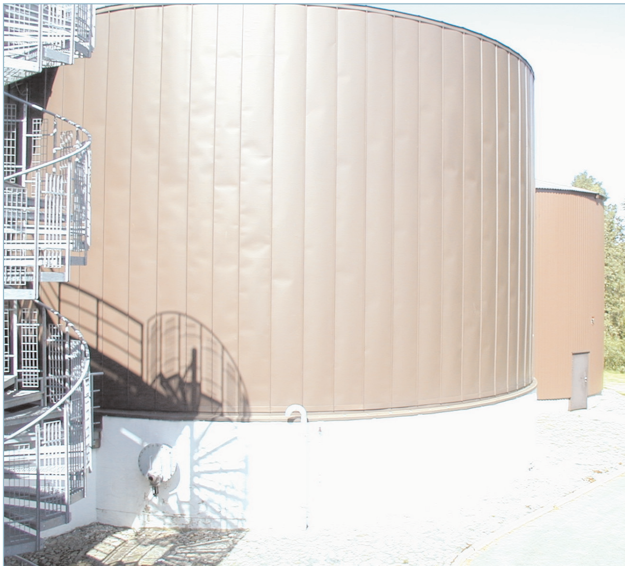
Råtnetank og gasstank som gjennomgikk 10 år's revisjon 2003.
